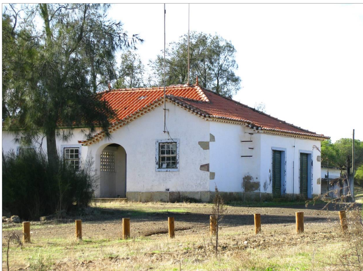
Figura 51: Casa do Guarda Florestal
