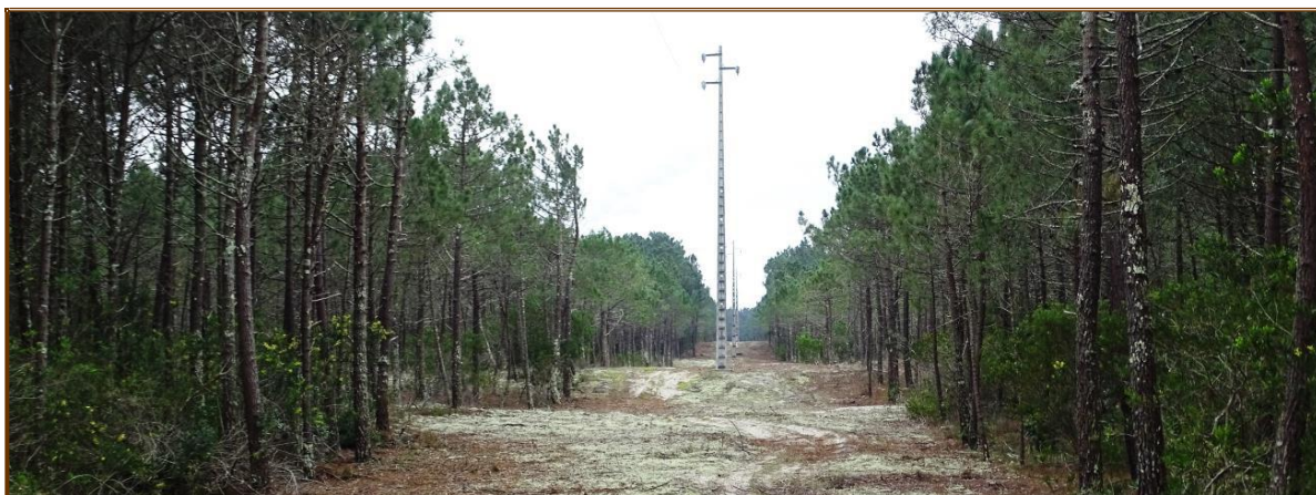
Figura 17 – Execução da faixa de gestão de combustível ao longo de uma linha elétrica – EDP.
