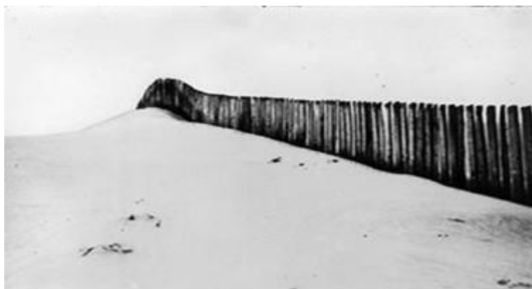
Figura 3 – Colocação de ripado ao longo da duna. Serviços Florestais, 1911.
