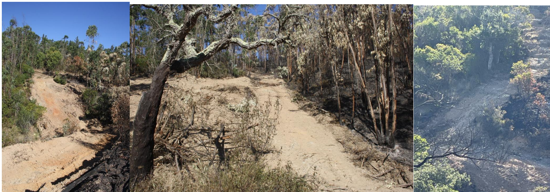
Imagem 9: Pormenor de linhas de trabalho de máquina de rastos
