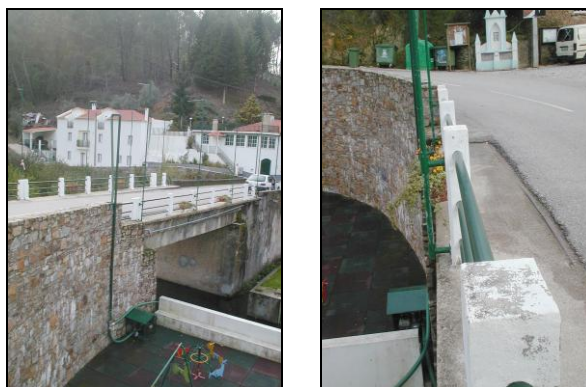
Figura 7 e 8 – Motobomba em Pessegueiro
