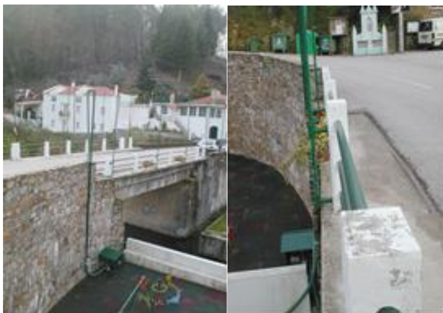
Figura 6. Motobomba em Pessegueiro
