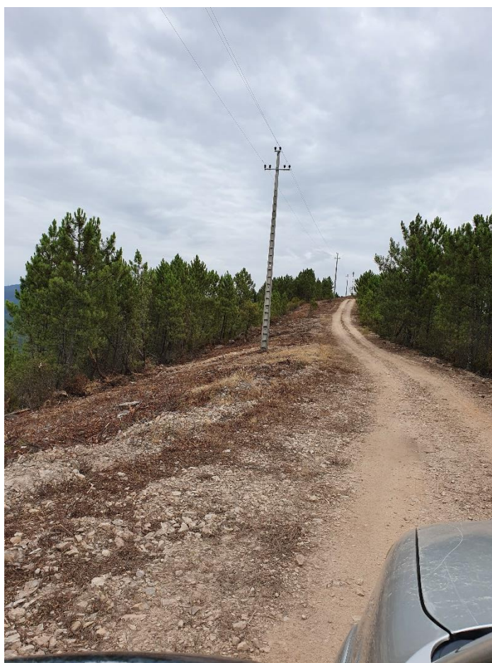
Figura 4. Faixa de Gestão de Combustível na rede viária florestal, executada em 2019 (3ª ordem)
