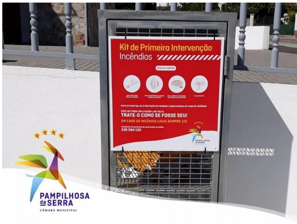
Figura 7. Kit de primeira intervenção aos incêndios
