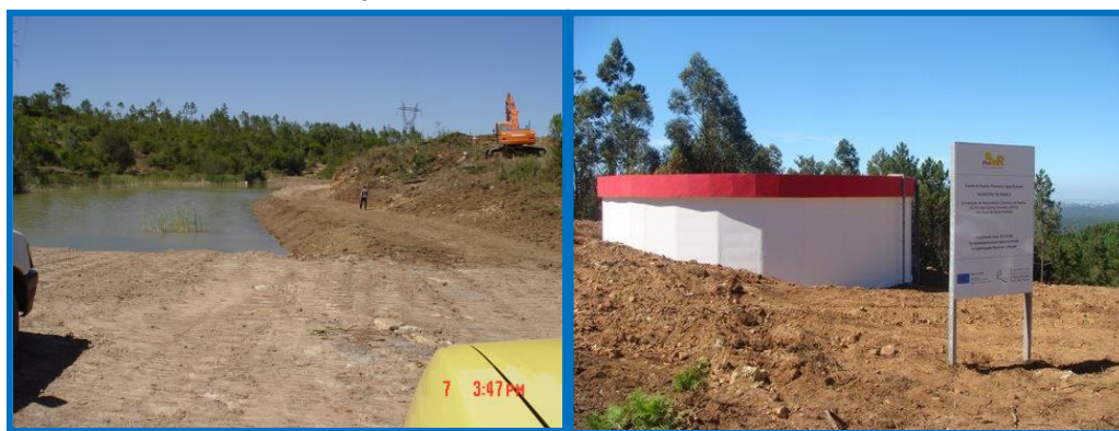
Figura 3 – Beneficiação e construção de pontos de água
