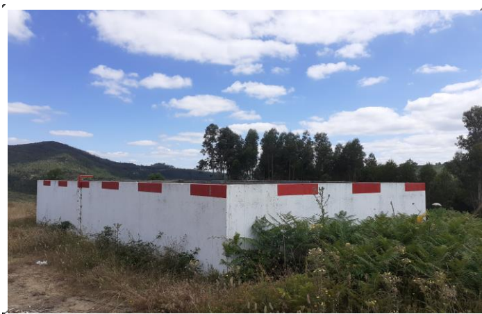
Figura 8– Beneficiação e construção de pontos de água
