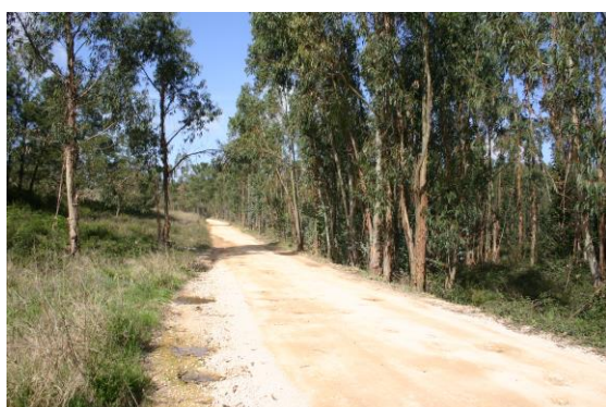
Figura 2.3 – Caminho a beneficiar 2014-2018 – regularização do piso, abertura de valetas, colocação de manilhas
