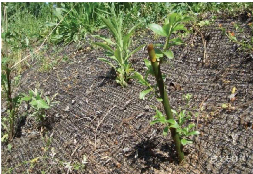
Ilustração 28 – Aplicação de estacaria viva – Fonte Ecosalix
