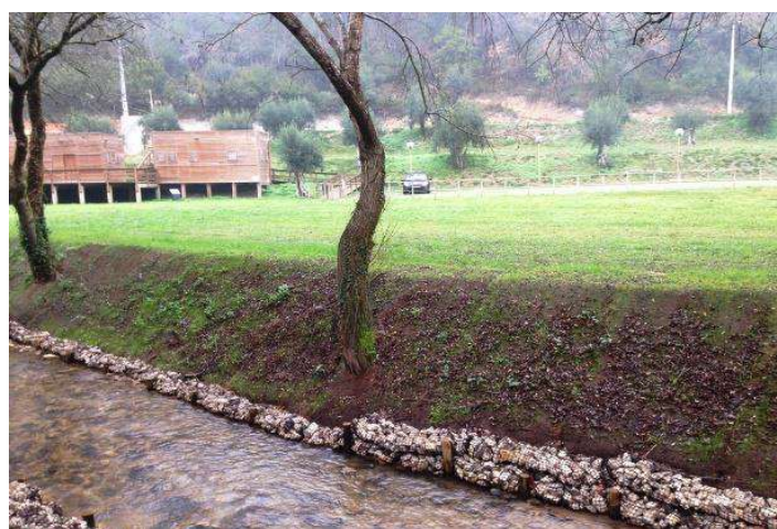
Ilustração 30 – Aplicação de gabião cilíndrico – Fonte Ecosalix
