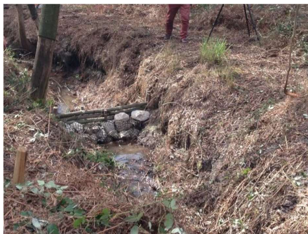
Ilustração 31 – Aplicação de micro barragens de correção torrencial– Fonte Ecosalix
