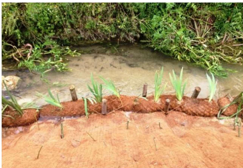
Ilustração 30 – Aplicação de bio rolo – Fonte Ecosalix
