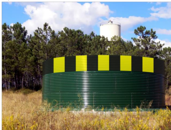
Figura 8 - Representação esquemática de pintura em depósitos de água
