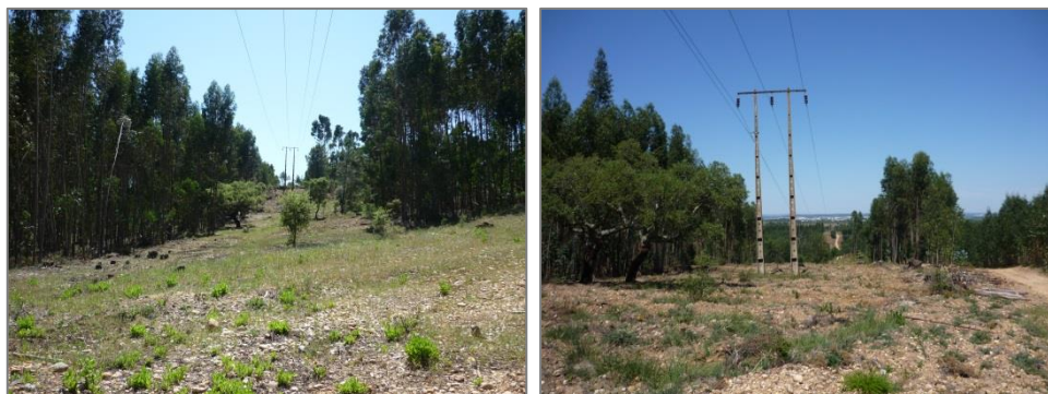
Figura 4 - Limpeza da linha da EDP (2º trimestre de 2009)
