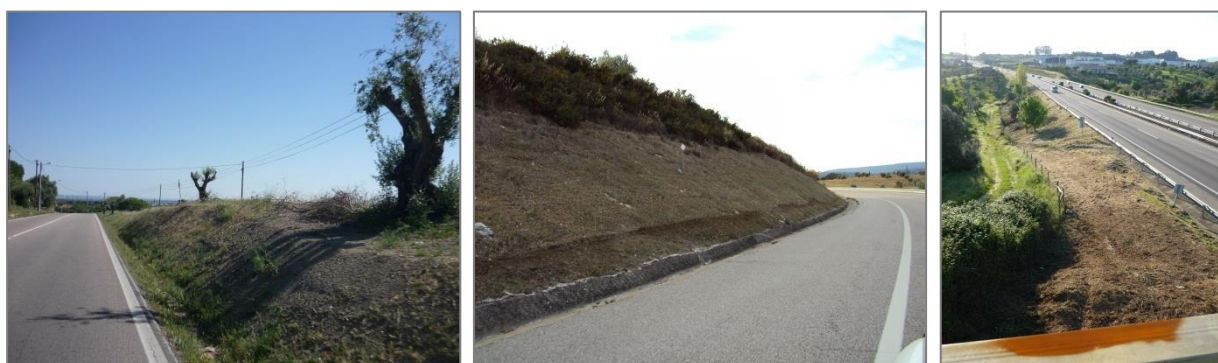
Figura 3 - Exemplos de gestão de combustível na rede viária em 2009 (à esquerda, limpeza da Estrada Nacional nº. 349; ao meio, limpeza da Estrada Nacional nº. 3; à direita limpeza na A23, na zona do hospital)
